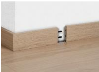
Verbindung von 2 Sockelleisten entlang der Wand
